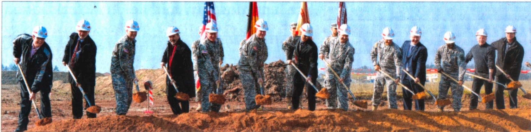
Bei schönstem Wetter wurde der Baubeginn des Versorgungszentrums am Urlas mit dem ersten Spatenstich zelebriert. Klaus Gerstendorff (Vierter von links), Leiter des Staatlichen Bauamtes Nürnberg, half bei der Planung. Foto: Sabrina Obergruber
