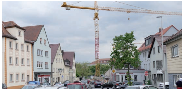
Der Kran in der Schlossstraße baut derzeit an einem Vier-Sterne-Hotel. Die OLA will sich künftig verstärkt für den Bau bezahlbarer Wohnungen in Ansbach einsetzen
